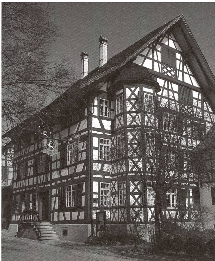
Ein Gasthof seit dem 17. Jahrhundert: Der Hirschen in Oberstammheim zeigt sich von aussen noch weitgehend im ursprünglichen Zustand.
