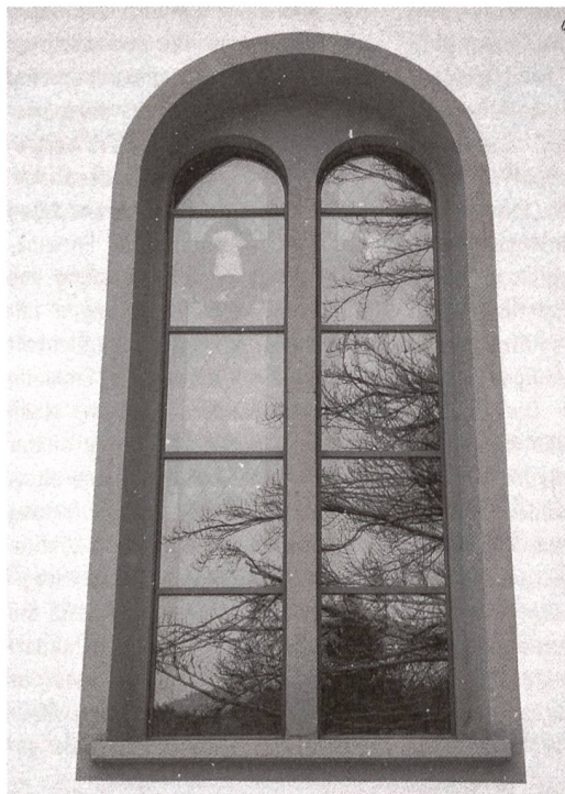
Aussenschutzverglasung mit Isolierglas. Bild links: Gesamtansicht; Bild rechts: Detailsicht.
