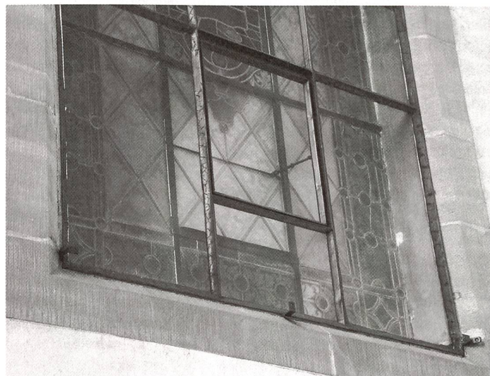
Einfache vorgesetzte Aussenschutzverglasung mit Lüftungsflügel in Metallrahmen in der Kapuzinerkirche in Romont (FR) von ca. 1950. Aufnahme kurz nach der Restaurierung.
