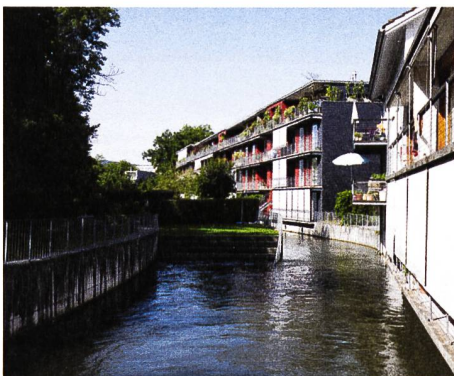
Die Siedlung im Lot von Michael Alder und Hanspeter Müller zeigt, wie Wasser und Wohnraum nahe beieinander liegen.
