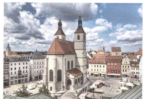
Abb. 4: Regensburg, Neupfarrplatz. Dieser Platz entstand 1519 durch die Zerstörung des jüdischen Viertels mit rund 40 Häusern. Im Zentrum des Platzes plante man eine monumentale Kirche, deren Bau aber nach der Errichtung des Polygonalaltars und der Chorschultertürme eingestellt wurde. Archäologische Untersuchungen 1995–1998 haben Keller der jüdischen Häuser und die Reste der Synagoge zum Vorschein gebracht. Letztere ist westlich der Kirche als marmornes Monument sichtbar gemacht worden. Die erhaltenen Keller sind heute Teil einer musealen Präsentation.
