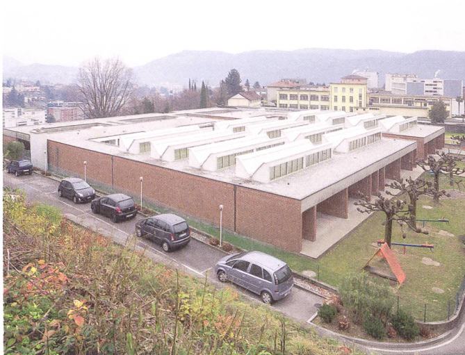
Fig. 8: Balerna, Scuola Materna (1971–1974), Ivano Gianola (*1944), dopo il restauro.
