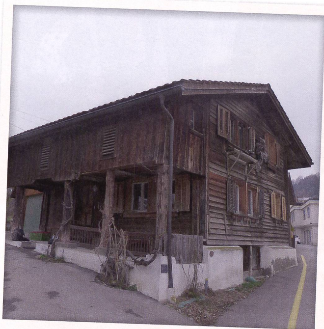
Blockbau von 1292/93 in Steinen.
