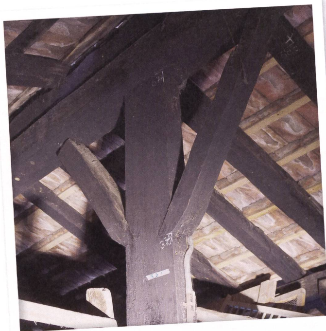
Dachstuhl von 1305 in einem Blockbau in Steinen.
