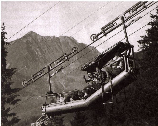
Die Luftseilbahn Bannalp funktionierte zu Beginn mit Wasserballastantrieb – davon zeugen die dicken Rohre unter der «Kabine».
