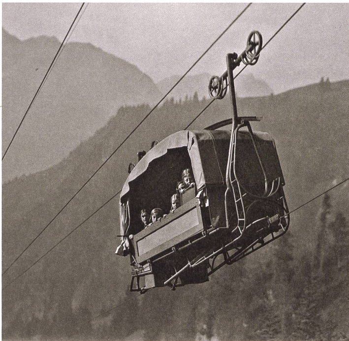
Schülerinnen-transport bei der Bergstation Niederrickenbach. Foto nach 1932.
