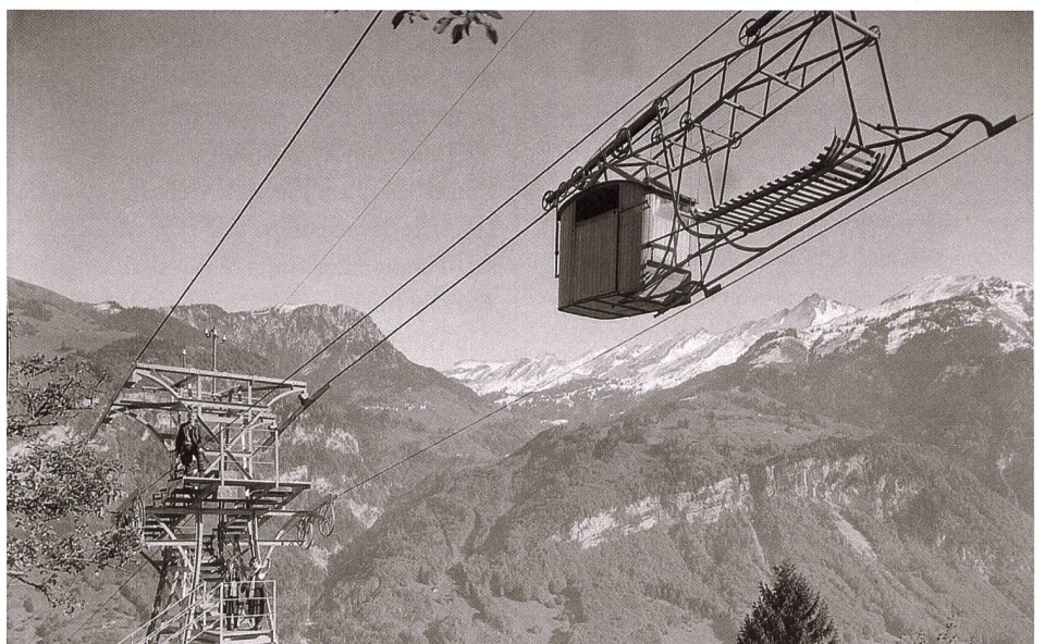
Die Luftseilbahn Dallenwil – Wiesenberg wurde ebenfalls von NSD Niederberger erbaut. Ungewöhnlich ist, das unter der Kabine und Ladebrücke geführte Zugseil. Foto 1935.
