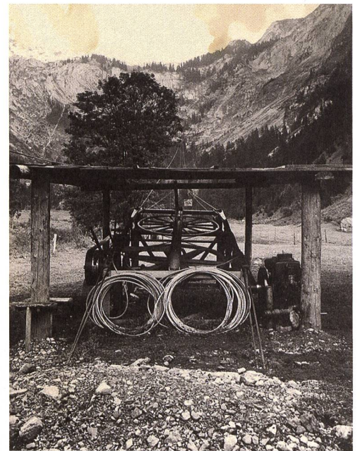
Talstation der Seilbahn Horbis-Arni bei Engelberg. Erbaut von Josef Odermatt.
