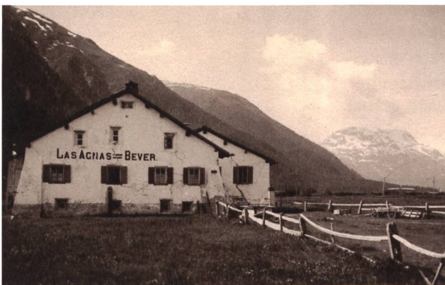
Der von Ulrich Campell beschriebene Weiler Las Agnas in einer historischen Aufnahme. 1929 wurde das Gasthaus abgerissen.
