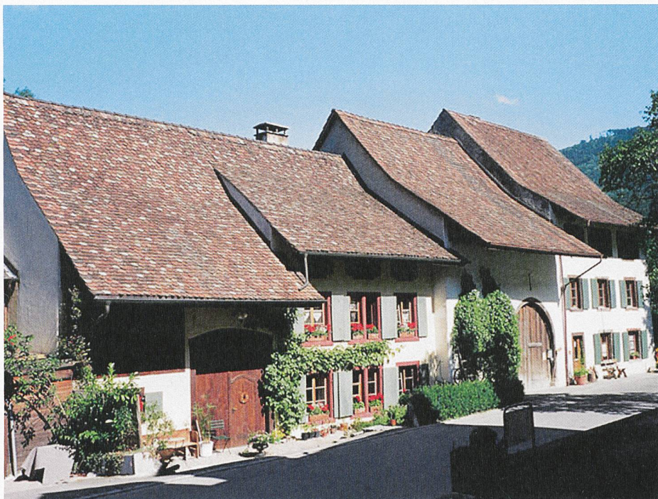
Ehemalige Posamentenhäuser mit geräumigem Wohnbereich und kleinem Landwirtschaftsteil prägen noch immer die Dörfer des oberen Baselbiets. Im Bild rechts ein Wohnhaus aus dem Jahr 1762 (Reigoldswil, 1999).
