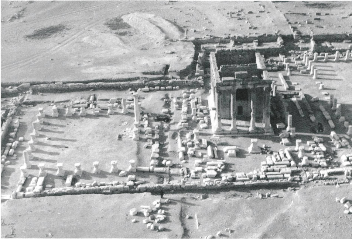
Sanctuaire de Baalshamîn après son dégagement (1956). © Fonds Collart, UNIL-ASA
