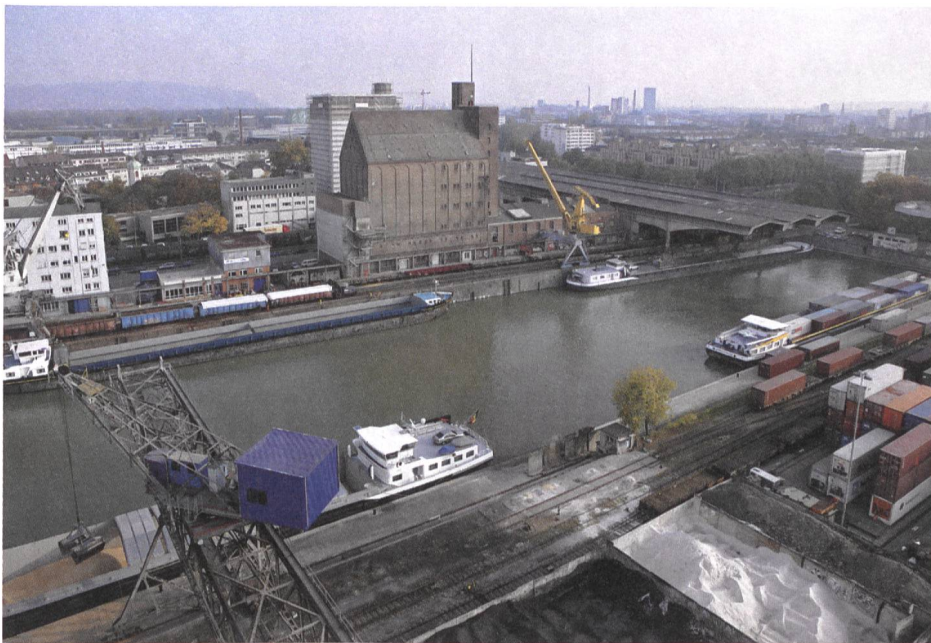
Der Bernoulli-Silo (1923–24) und die Freivorbau realisierte Tragkonstruktion in vorge-spanntem Beton des Umschlaghofs (1952–53) auf dem Ostquai des Rheinhafens Kleinhüningen.
