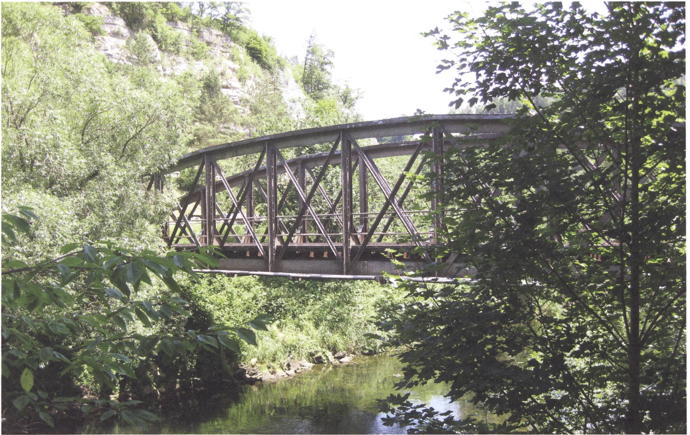
Halbparabelträgerbrücke von 1895 über die Birs bei Liesberg BL. © EKD
