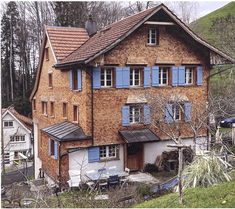
Die ehemalige Mühle Sägentobel in Walzenhausen AR steht unter Denkmalschutz. Man nimmt an, das Haus stamme aus dem 18. Jahrhundert. Es ist schon oft umgebaut worden. Nun sind drei Fassaden neu isoliert und geschindelt.
