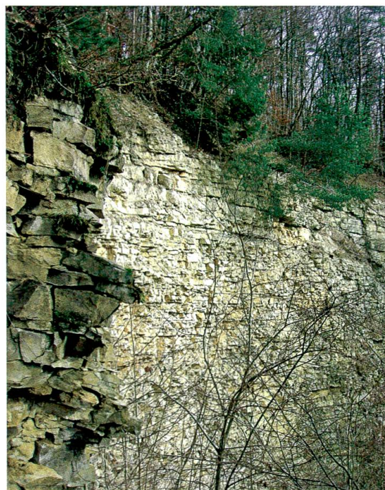
40 Aufschluss Hemmentalertal Summerhalde, wenig Erd- bzw. Humusüberdeckung, viele Spalten und Klüfte, wenig Reinigungswirkung. Foto: ALU
