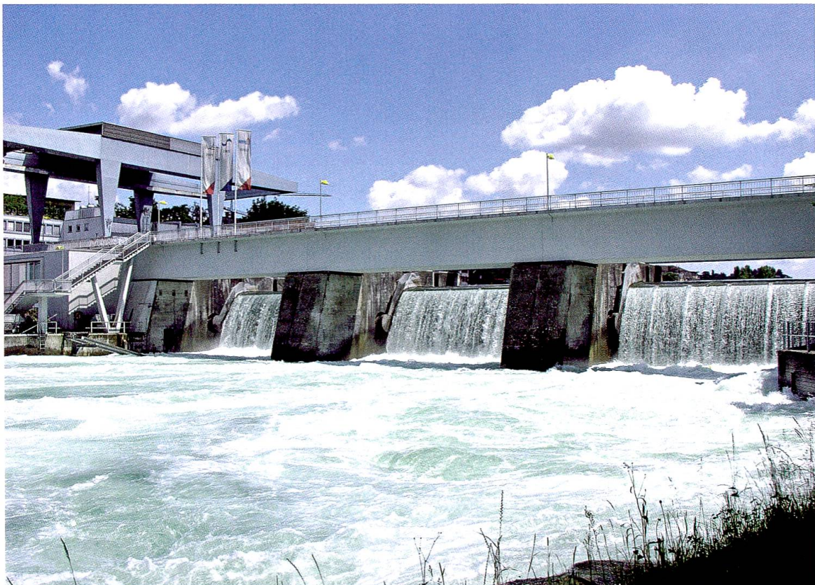
97 Kraftwerk Schaffhausen bei Hochwasser. Foto: Max Baumann
