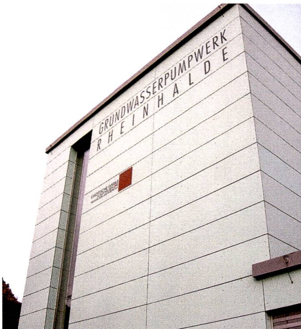
Pumpwerk Rheinhalde, 100 Jahre später. Foto: Kantonales Labor
