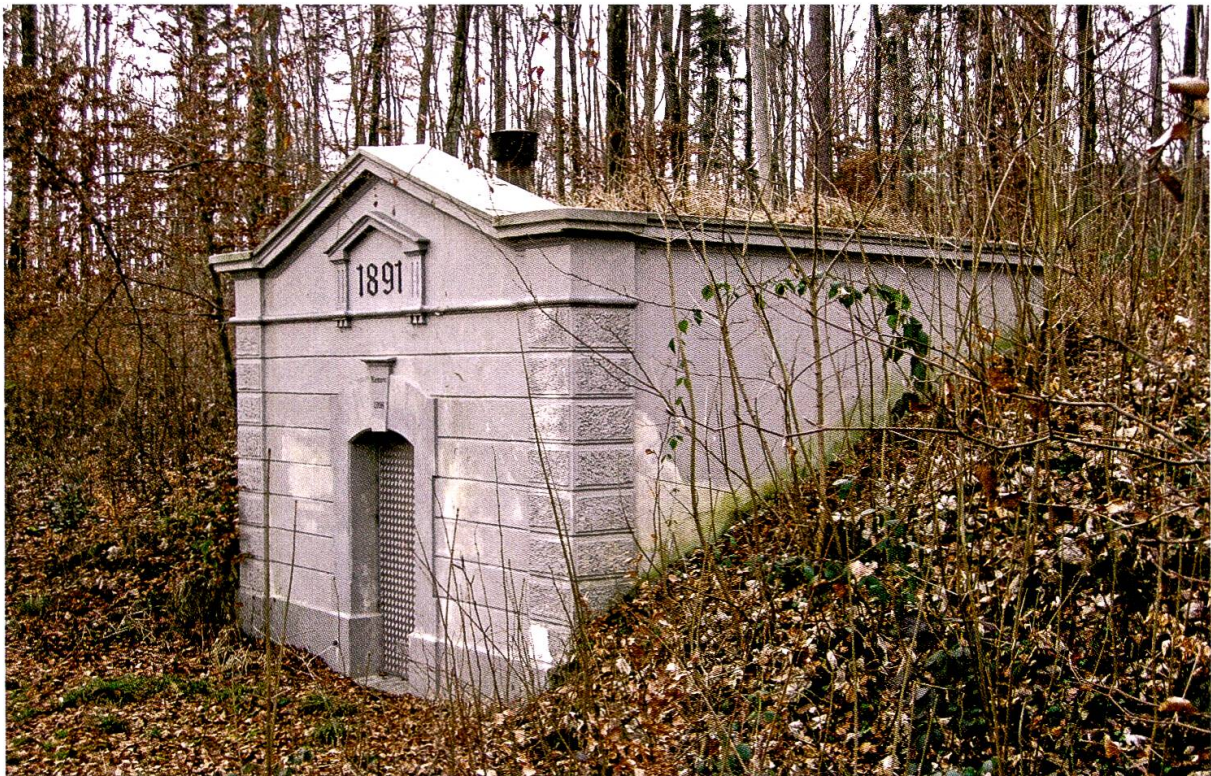
Typisches Reservoir um die Jahrhundertwende: Reservoir auf dem Säkelamtshüsli: Das Wasser kam von einem städtischen Grundstück der Gemarkung Hemmental und war für die «Irrenanstalt», heute Psychiatrische Klinik Breitenau, bestimmt. Foto: Kantonales Labor
