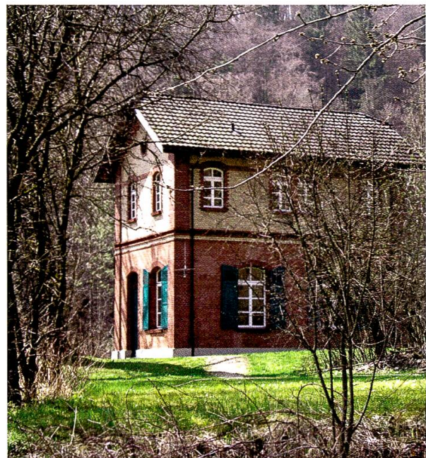
Pumpwerk Engestieg, Inbetriebnahme 1901. Der Bau zeugt von der dem Trinkwasser entgegengebrachten Wertschätzung der Bauherren. Foto: Kantonales Labor
