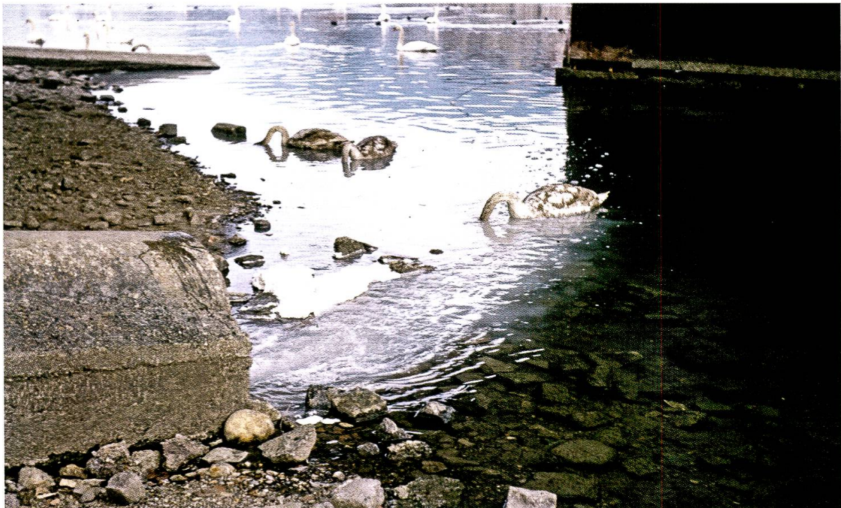
Abwasserrohr im Bereich der Rheinbrücke von Stein am Rhein 1969. Foto: Kantonales Labor
