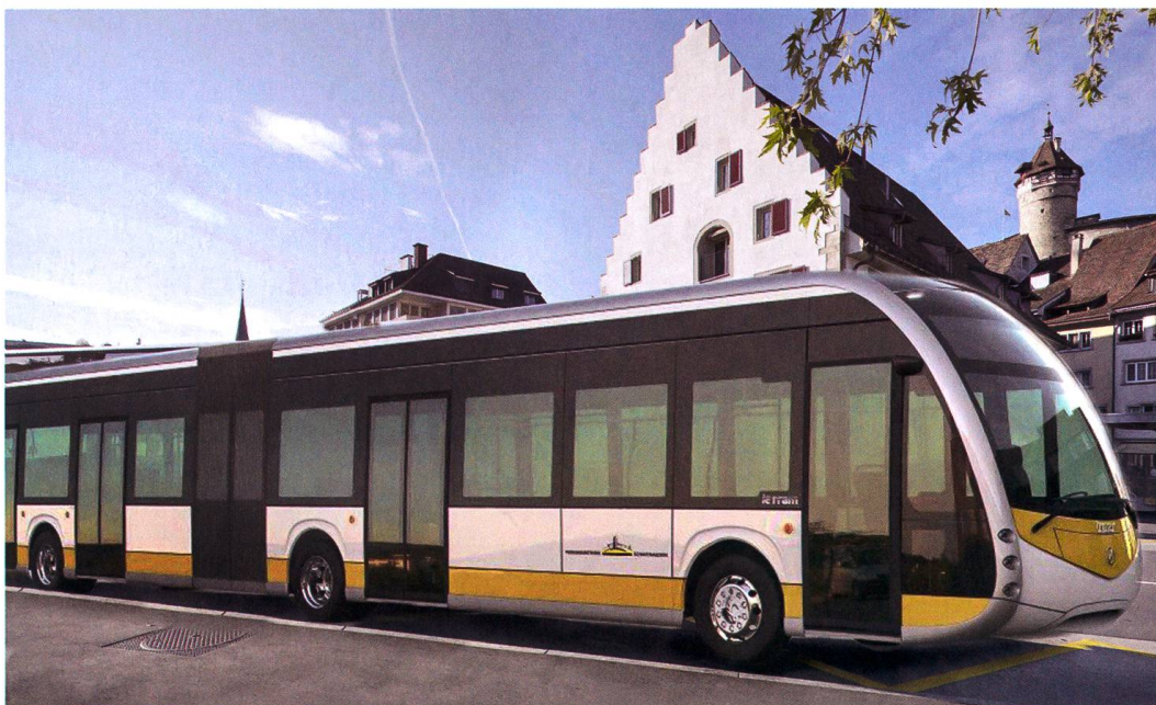
Abb. 14: Die Stadt Schaffhausen setzt bei ihrem Busverkehr auf Batterie. In den nächsten zehn Jahren wird die gesamte Dieselbusflotte der Verkehrsbetriebe Schaffhausen (VBSH) durch Elektrobusse ersetzt. Die Stimmberechtigten haben dem entsprechenden Kredit für die «Einführung von Elektrobusen mit Schnellladesystem» über rund 58 Millionen Franken mit rund 54 % Ja-Anteil deutlich zugestimmt. (Quelle: Stadt Schaffhausen)
