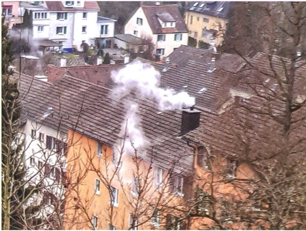
Abb. 8: Eine instabile atmosphärische Schichtung ergibt ein mäanderartiges Auf und Ab der Rauchgasfahne. Die Turbulenzen führen zu einer raschen Verdünnung der Rauchgase. Typisch auch die «heruntergezogene» Abgasfahne auf der dem Wind abgewandten Seite des Gebäudes. Dies ist die Folge eines Lee-Wirbels und wird in der Fachwelt als Downwash-Effekt bezeichnet. (Quelle: eigenes Bild; zur Erklärung siehe auch Abbildung 9)
