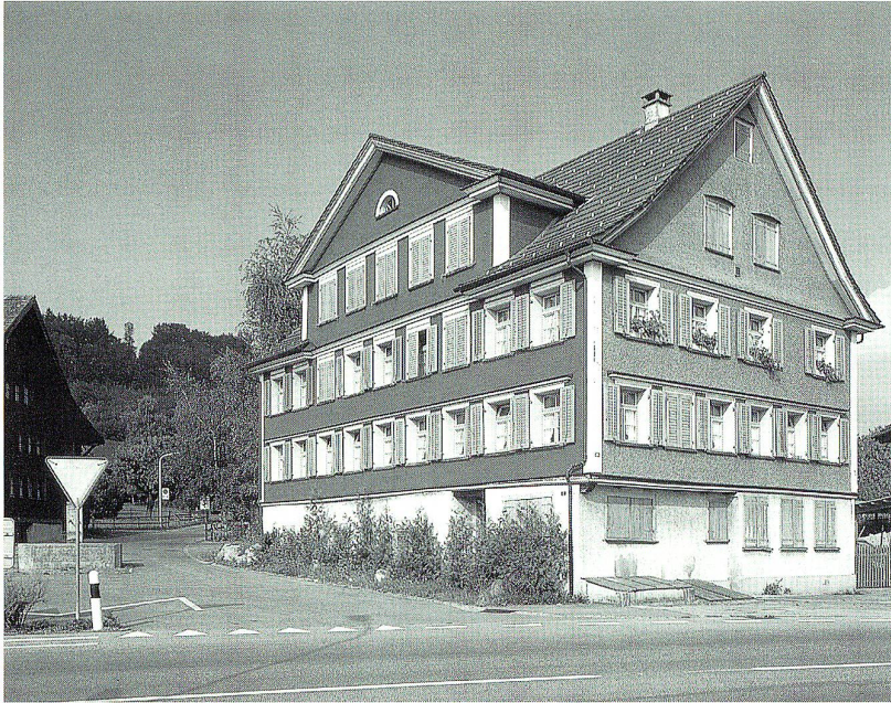
Oben: Schutzobjekt Oberdorfstrasse 2, der ehemalige «Löwen», über älterem Kern um 1830 im Biedermeierstil umgebaut.
