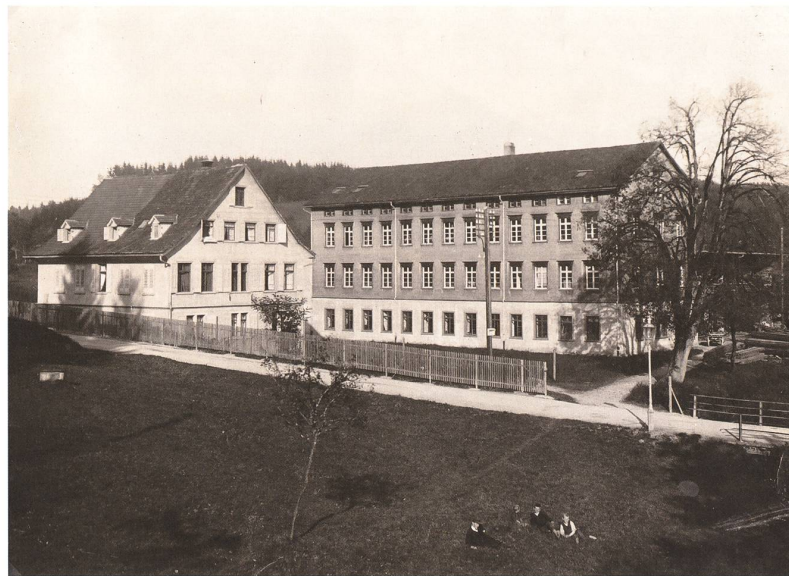
Mühlebaufirma Glarner + Co. AG, ca. 1910.
