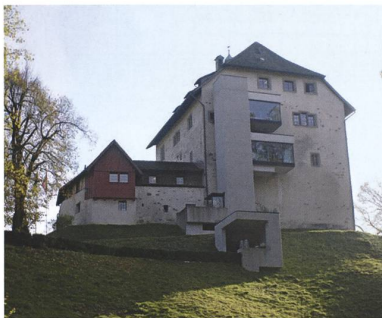
Ansicht von Schloss Oberberg von Norden, mit 2009 fertiggestelltem Liftanbau. Aufnahme 2014
