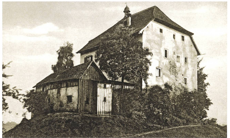
Defekte Nordmauer und WC-Anbau Söldnerhaus
