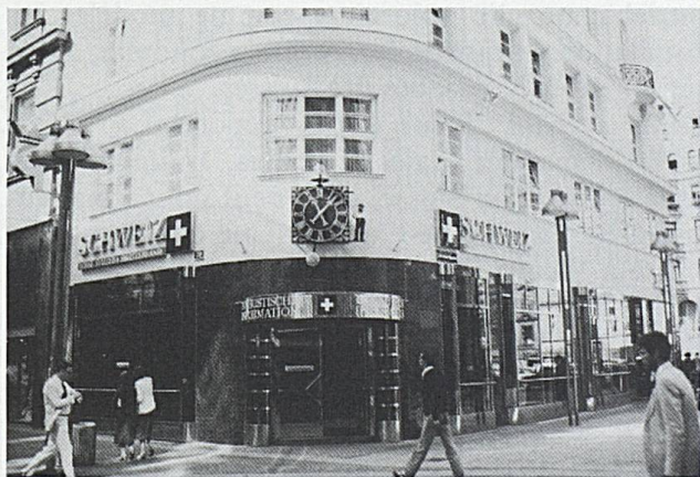
Nouvelle façade de l'agence de Vienne
