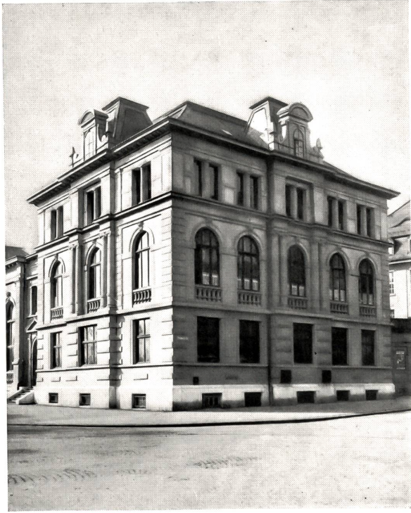
Heutiges Bankgebäude am Aarequai
