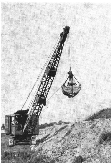
Abb. 7 Bagger an der Dünnernkorrektur
