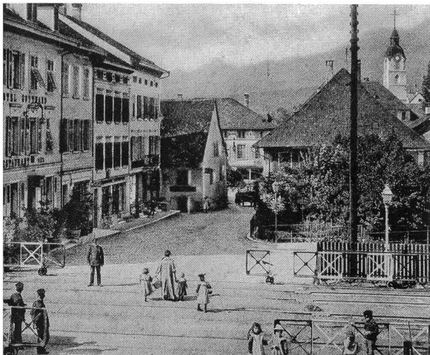
Bahnhofstraße mit Schieebarriere und links 2. und 3. Haus die Liegenschaft Moor
