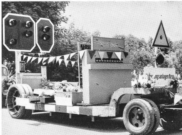
Elektrisches Stellwerk mit Geleisebild und Licht-Tagessignalen
