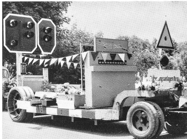
Elektrisches Stellwerk mit Geleisebild und Licht-Tagessignalen
