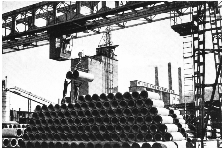
Lager von Durobeton-Rohren im Werk Olten der AG. Hunziker & Cie.
