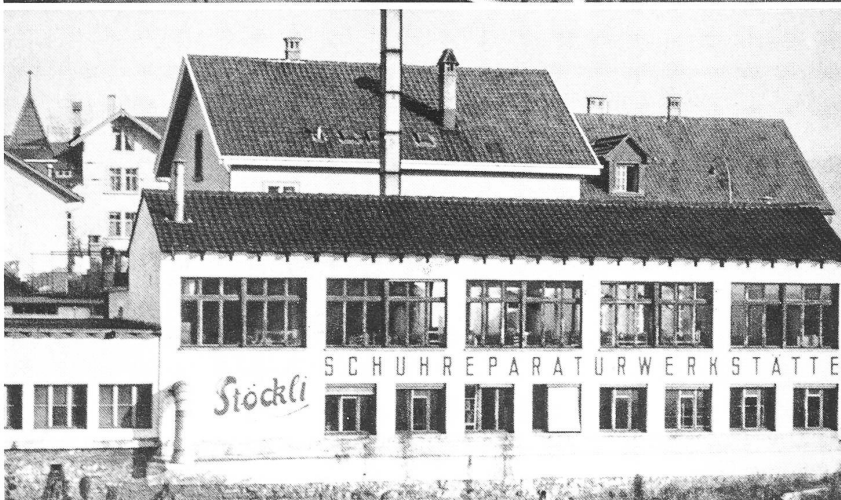
Erster Bau Aarburgerstrasse
