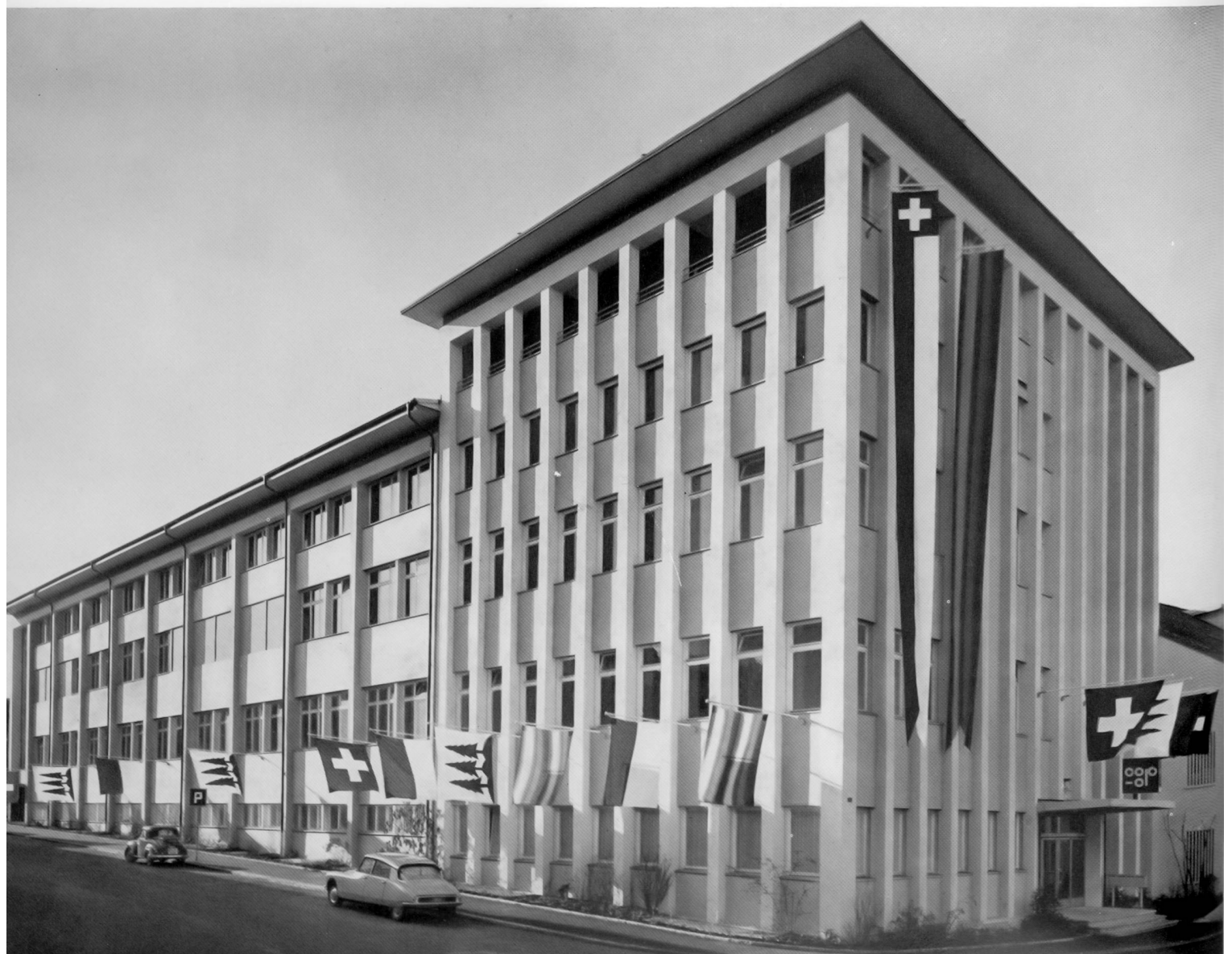
Gesamtansicht der neuen Zentralbetriebe
