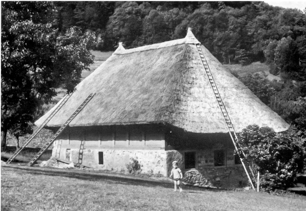
Außenrenovation beendet, Juni 1963. West- und Südseite. Foto U. Wiesli
