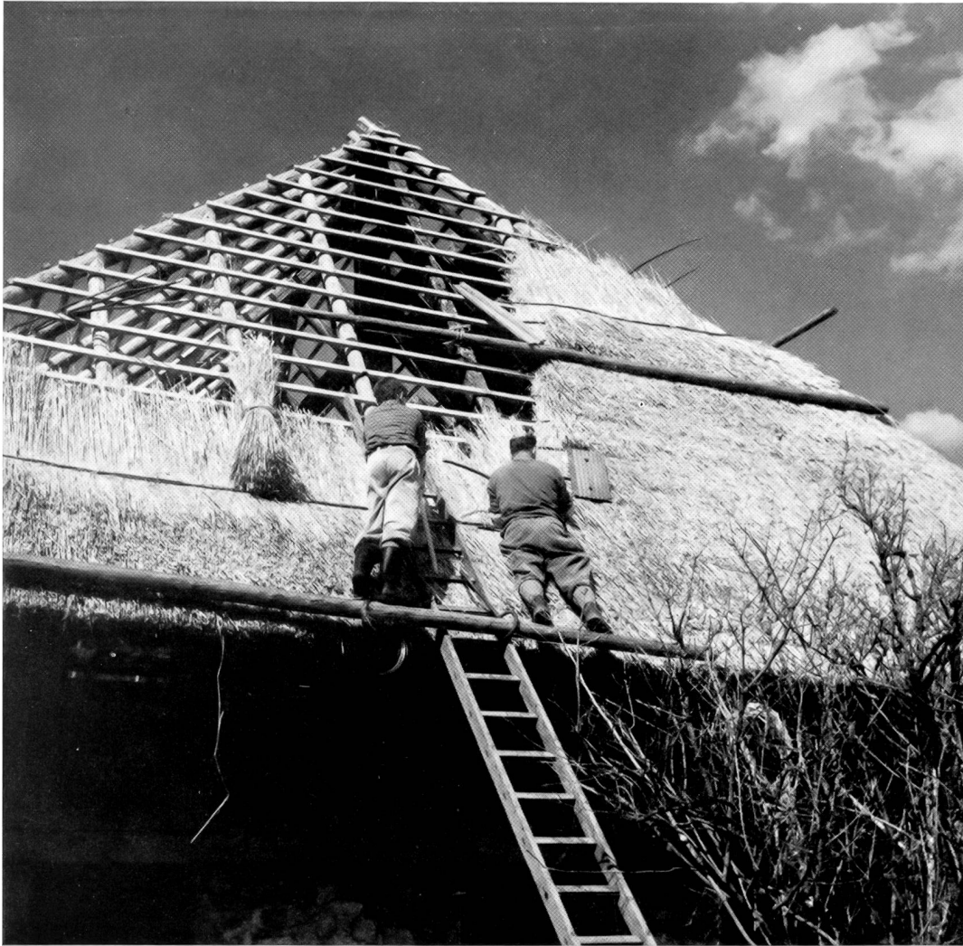
Eindecken, Frühling 1963. Auf dem Mastbaum Dachdeckermeister H. Waßmer aus Aarau. Foto W. Zeller, Zürich
