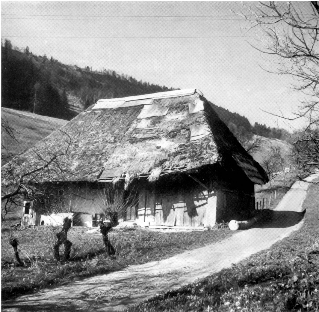
Zustand 1961 vor der Renovation. Ostseite mit Eingang und Tennstor. Seit fast 30 Jahren nicht mehr bewohnt. Foto W. Zeller, Zürich
