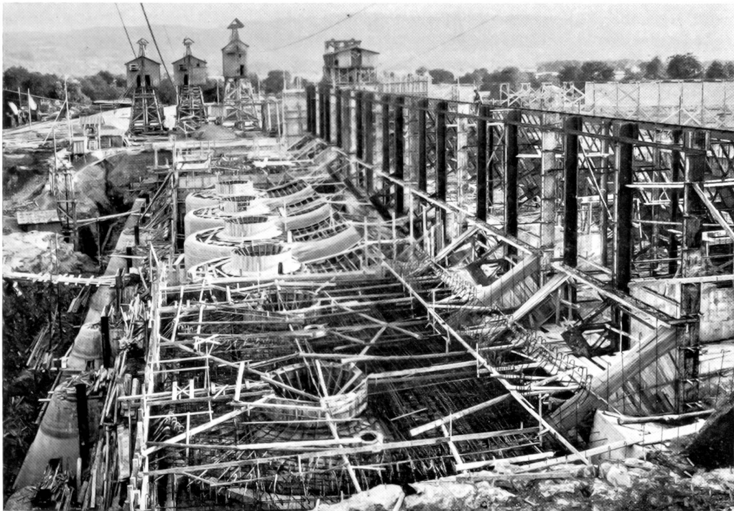
Das Maschinenhaus Gösgen ist im Bau (Verschalung der Turbinen 3—6).
