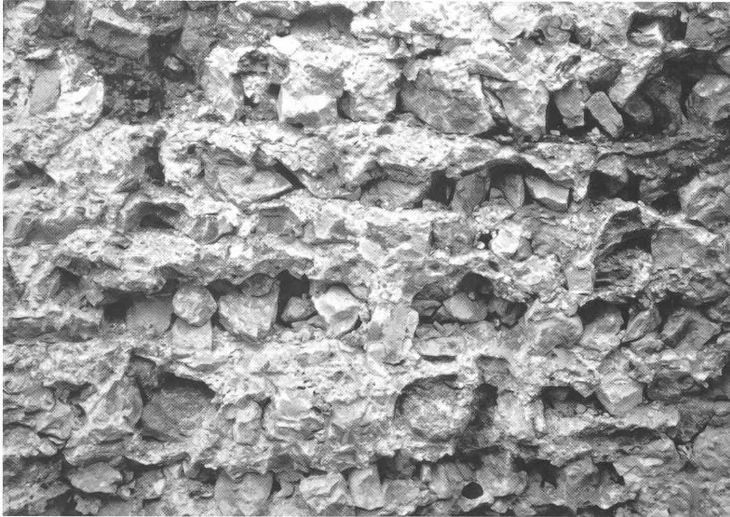
Olten, Klosterplatz Nr. 15. Beim Abbruch der Castrummauer zeigt sich im Querschnitt deutlich der lageweise Bau. Photo Ernst Müller.
