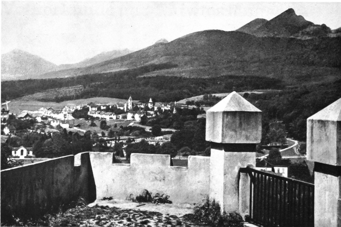
Der im Jahre 1896 erstellte Aussichtspunkt Hardfluh. Blick gegen den schwach überbauten Schöngrund. Links am Bildrand die Totenkapelle des Burgfriedhofes. Im Stile der Zeit wurde die Anlage mit Ecktürmen und Schiess-Scharten gebaut.
