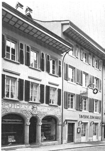
Hauptgasse nach Umbau 1978
