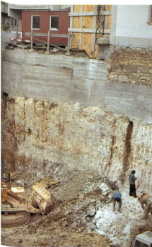
Felsaushub für Neubau in Olten.
