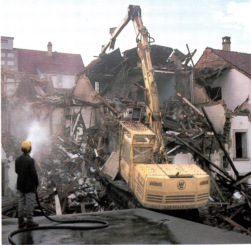
Abbrucharbeiten durch Bagger mit Spezialausleger.
