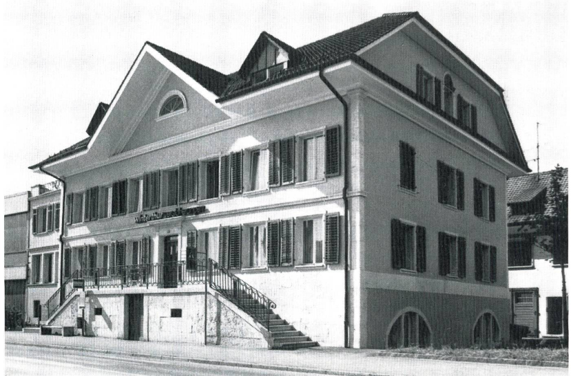
Heute steht das ehemalige Josefshaus an der Solothurnerstrasse 101 in Olten in neuem Glanz da.
