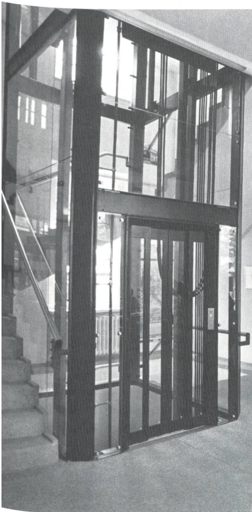
Der eingebaute Lift ermöglicht es auch Gebbehinderten, das ganze Museum zu besuchen.
