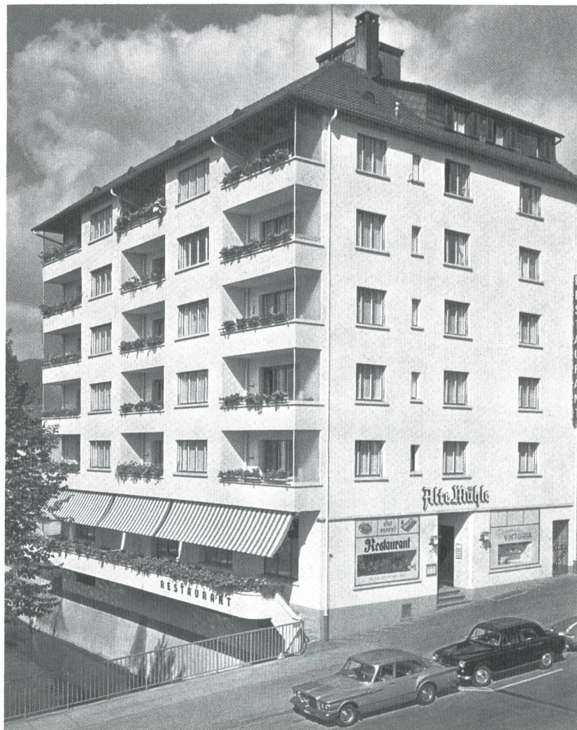
Das Restaurant «Zur Alten Mühle» nach der Renovation von 1962/63.
