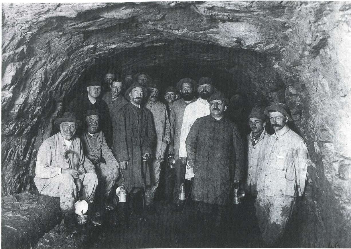
Arbeiter im Tunnel mit Karbidlaternen. (Historisches Museum Olten).
