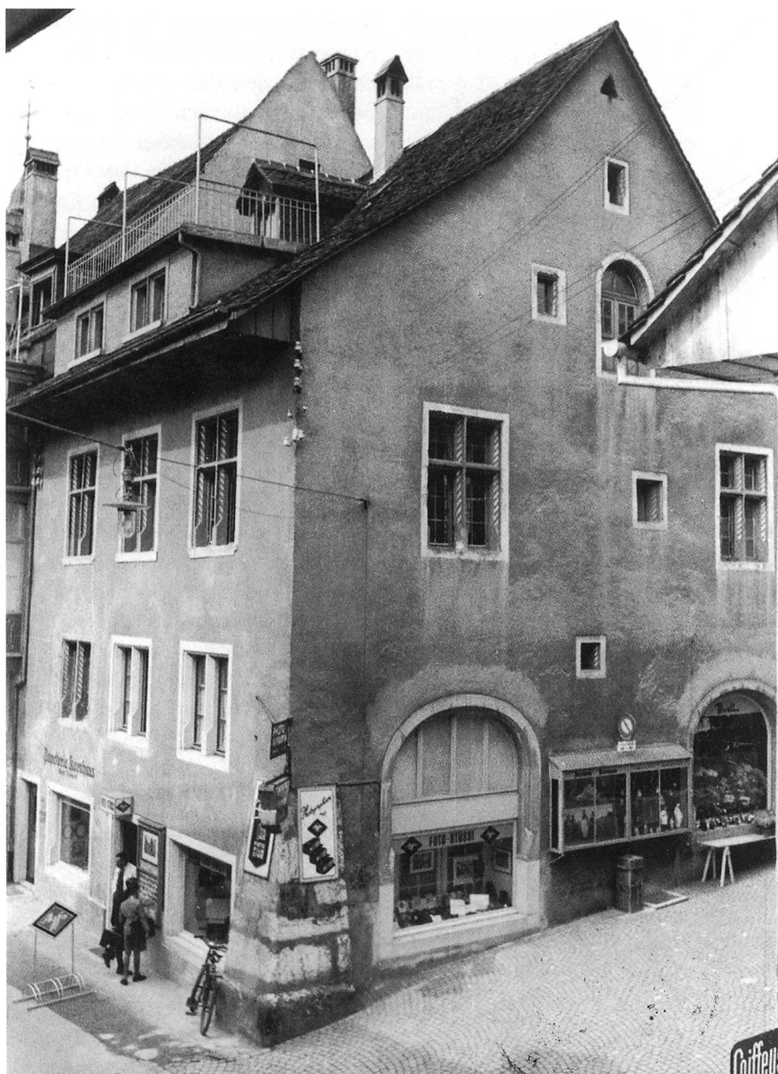
Das Kauf- und Kornhaus von 1598 nach dem ersten grösseren Umbau. Original sind nur noch die mächtigen Kreuzfenster im Obergeschoss und auf der Seite gegen die heutige «Fröschenweid» zusätzlich die kleinen Fenster und die rundbogige Öffnung.
