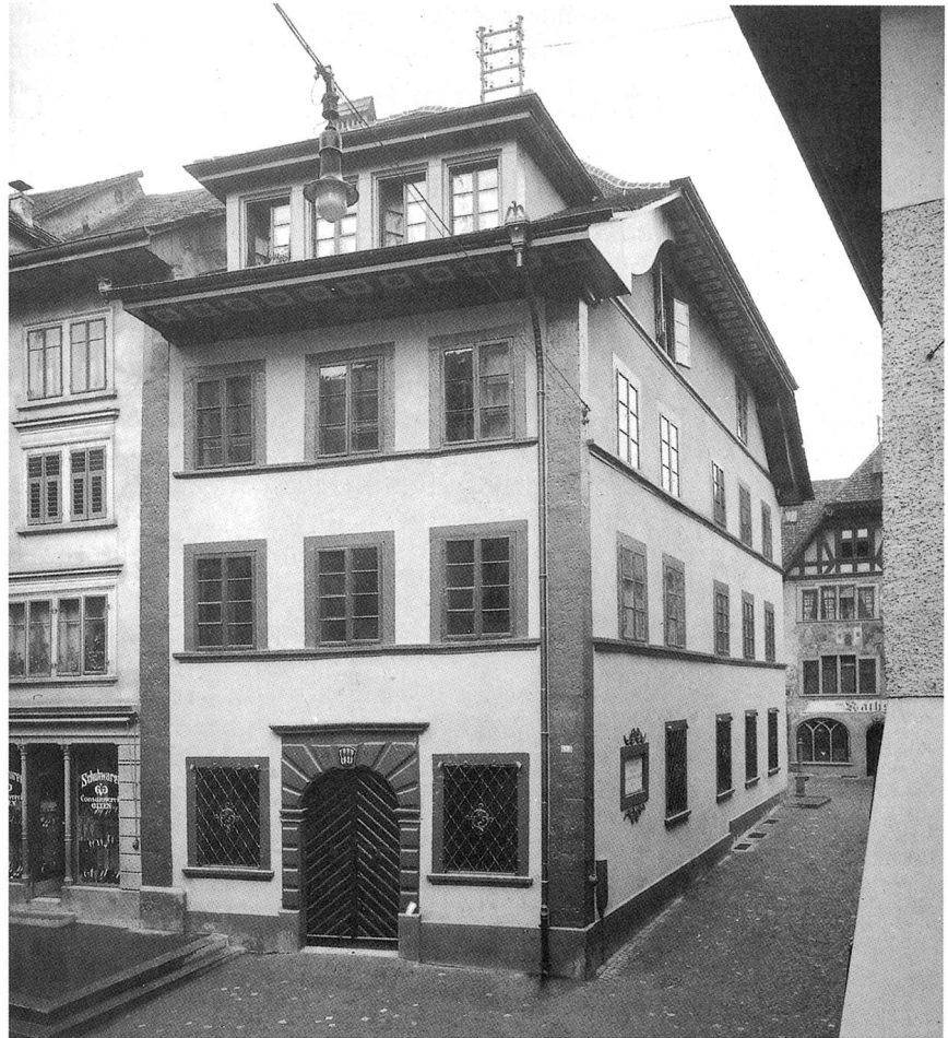
Das Oltner Rat- und Kaufhaus von 1705 nach dem Totalumbau von 1925, bei welchem das ganze Haus ausgehöhlt wurde! Das grosse Tor mit dem Stadtwappen sicherte ursprünglich den Zugang zum städtischen Kaufhaus. (Zur Ratsstube, zum Tanzsaal und zu der Weibelwohnung im Dachgeschoss gelangte man vor dem Umbau von der Breitseite her über eine Treppe.)
