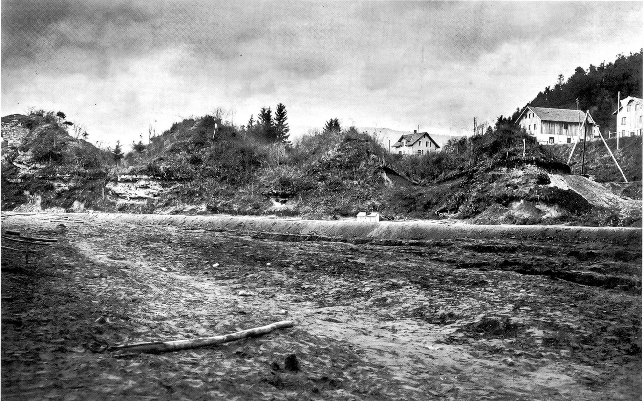
Aufnahme der ehemaligen Holz-Erdburg Obergösgen mit den drei Wällen, die als Annäherungshindernisse erbaut wurden. Seit der Aarekorrektur von 1870 steht die Burg nicht mehr am Wasser; ausserdem sind die Wälle 1914/15 dem Bau des Aarekanals zum Opfer gefallen.
