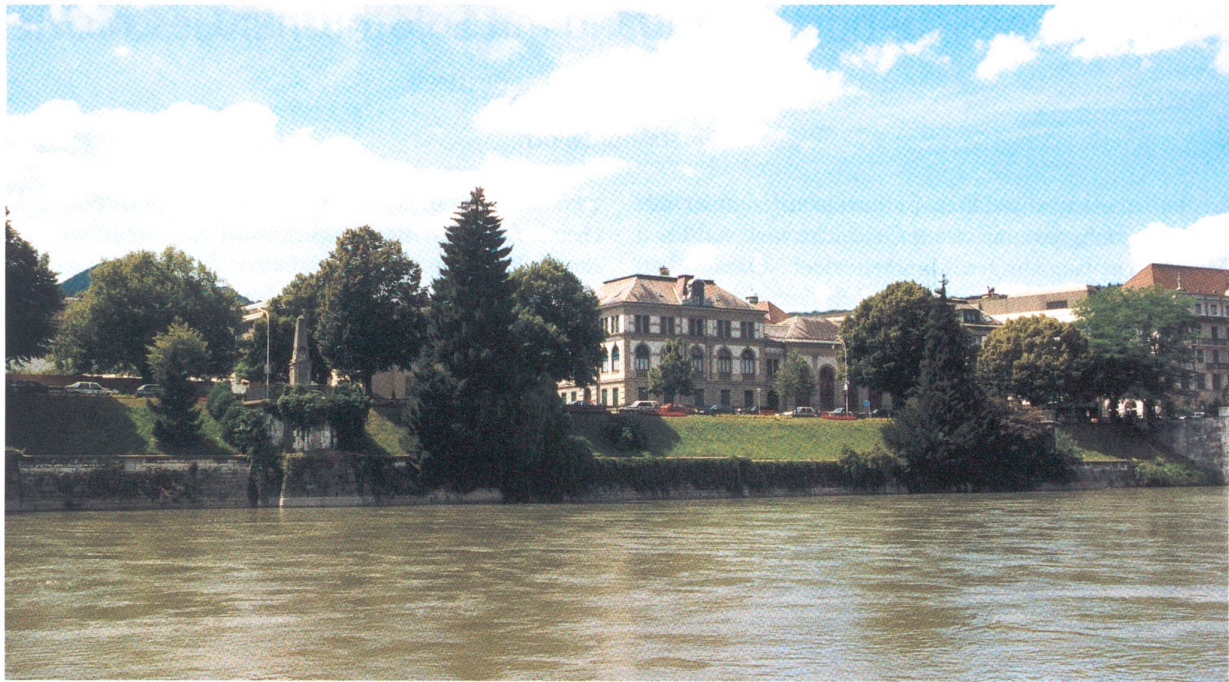
Amthausquai heute: Die ehrgeizige Anlage verschwindet zusehends unter einem dicken Kleid aus Bäumen, Büschen, Ranken und Moos.
