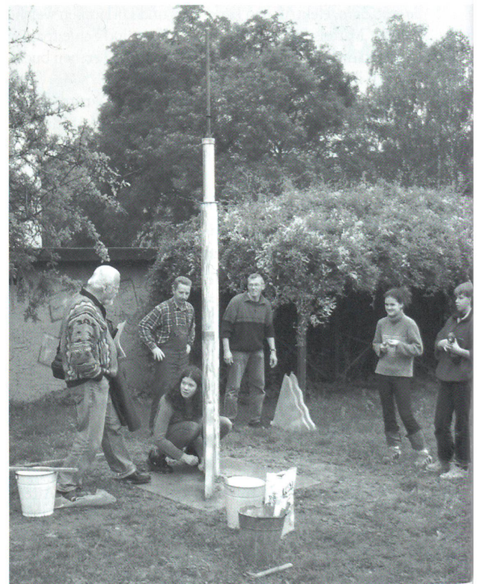
Der Mast ist gesetzt.
