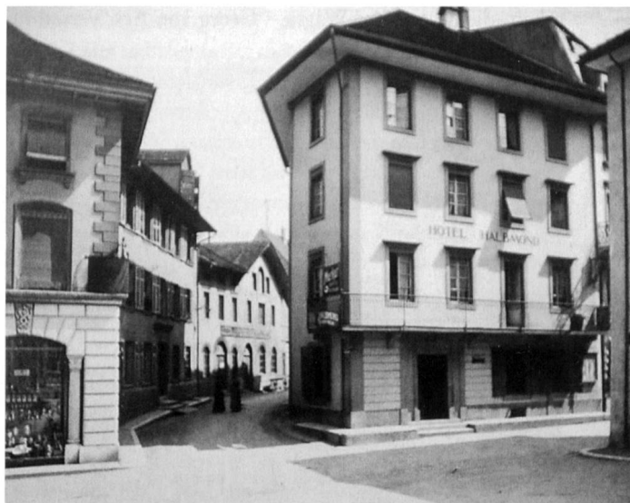
Halbmond nach dem Umbau
