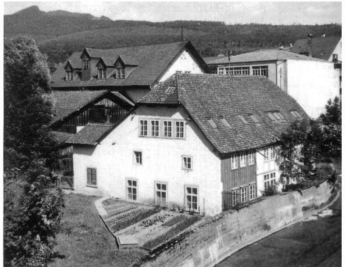
Die ehemalige Büttiker-Ölmühle oberhalb der Brücke zum Bahnhof Olten Hammer anno 1969
