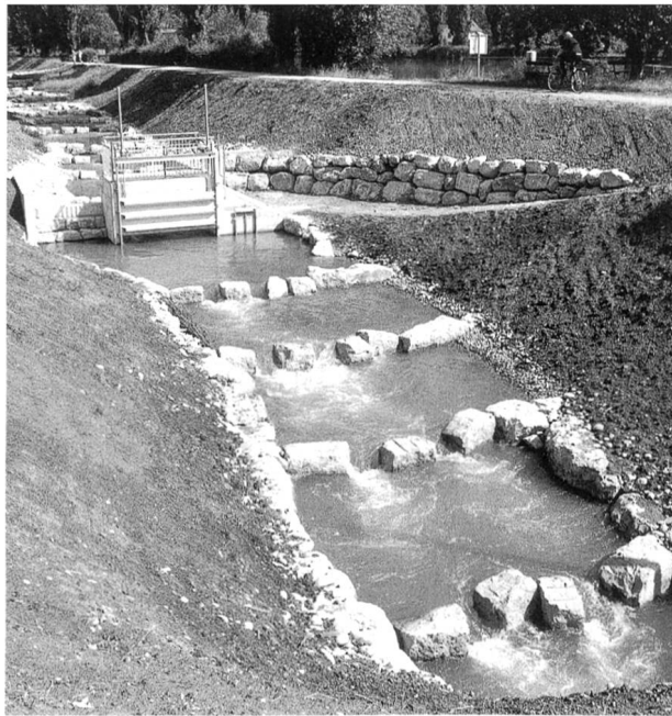
Die neu erstellte Fischtreppe beim Stauwehr Winznau
