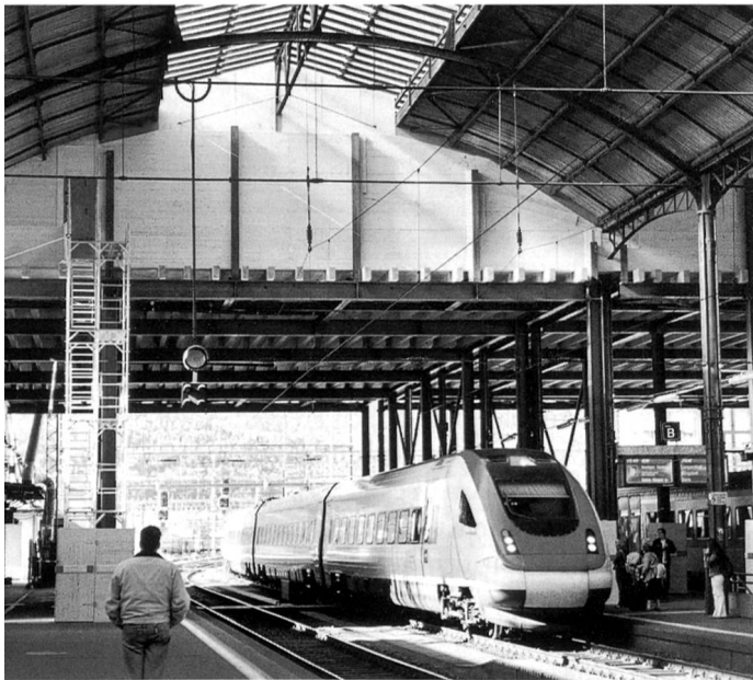
Sanierung der Bahnhofhalle
