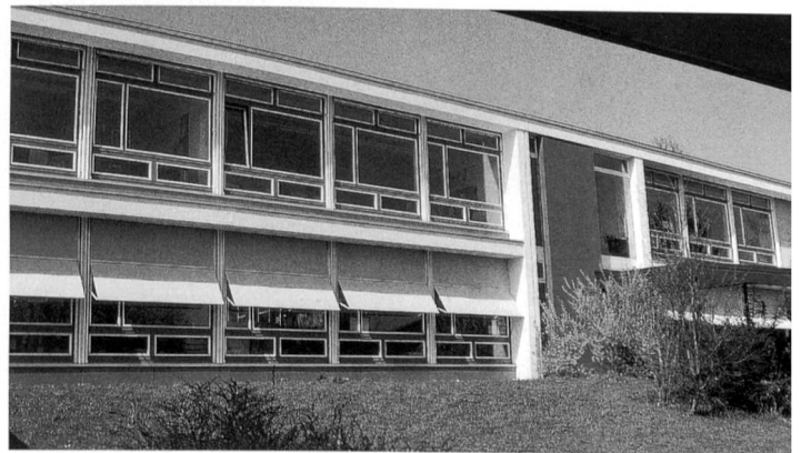
Südostansicht des frisch sanierten Klassentraktes/Ausschnitt
