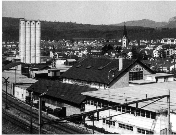
Blick über das im Olten-Hammer aufgeschüttete «Plateau». Im Hintergrund das 1952 errichtete Getreidesilo
