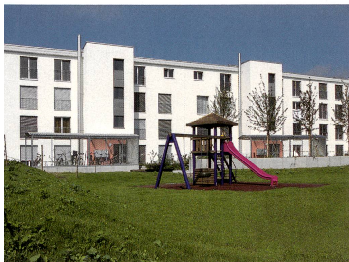
Neubau Mehrfamilienhäuser im Kleinholz
