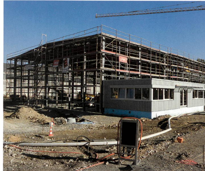
Rohbau der ERO-Frikart AG am Rötzmattweg
