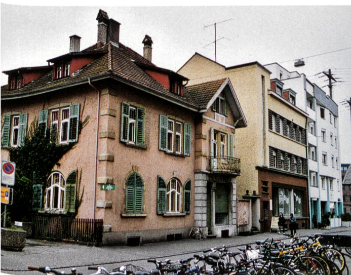
Häuserreihe an der Martin Disteli-Strasse vor dem Abriss
