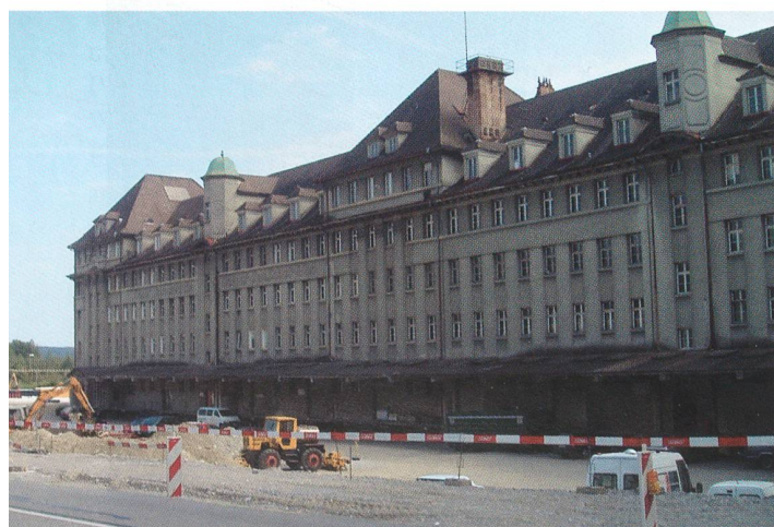
Das Usengo-Gebäude wird für die Kantonspolizei umgebaut.
