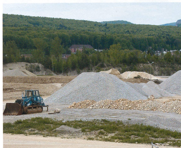
Impressionen vom Rückbau 2005
