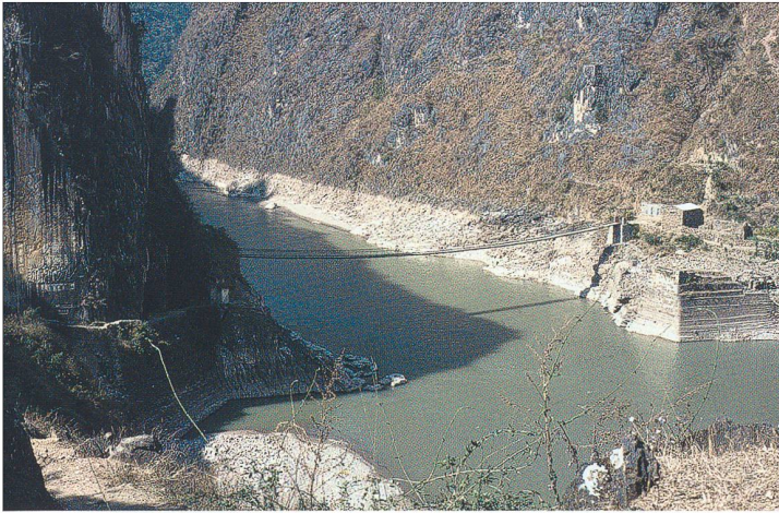
Die am Karawanenweg 1475 erbaute Jihongbrücke über den Mekong ist von Bao Shan auf zum Teil miserabler Strasse und zuletzt nur noch zu Fuss erreichbar. Sie wurde 1986 durch ein extremes Hochwasser weggerissen. Die Ketten liegen noch auf den Felsen, die Brückenköpfe sind teilweise eingestürzt. Ein Stahlseilsteg verbindet nun die beiden Ufer. Links im Bild im gelben Fels sind Inschriften eingemeißelt: erste Brücke nach Südwesten, von Menschenhand gemacht. (siehe auch Bild unten)
